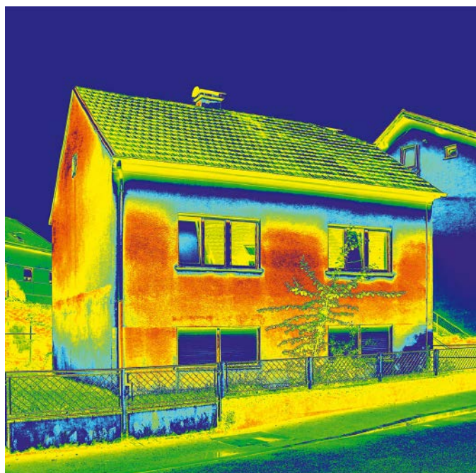
Rysunek 3. Obrazowanie termiczne jest też stosowane do kontroli izolacji termicznej budynków
